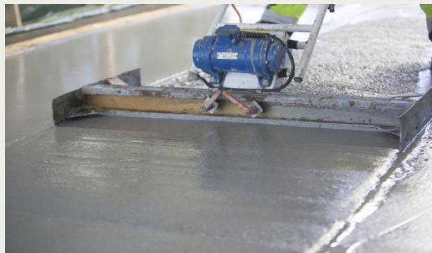
Figur 1. Utläggning av hårdbetong med vibrobalk.
