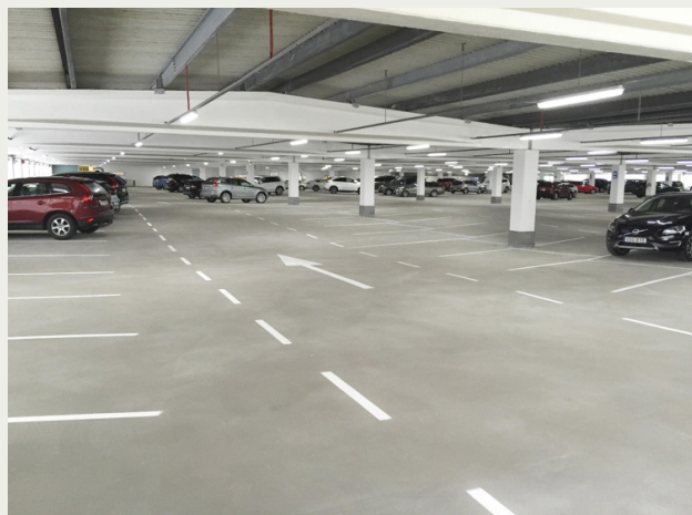
Figur 2. Nytt hårdbetonggolv i garage.
